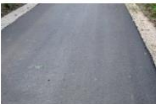
Droga gminna w m. Jawornik-Przedmieście Wartość kosztorysowa - 45 405,54 zł Wartość kosztorysu ofertowego - 33 968,85 zł
