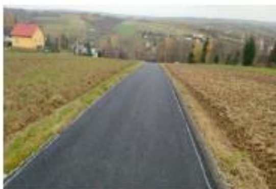
Droga gminna w m. Jawornik-Przedmieście Wartość kosztorysowa - 100 067,45 zł Wartość kosztorysu ofertowego - 52 968,54 zł
