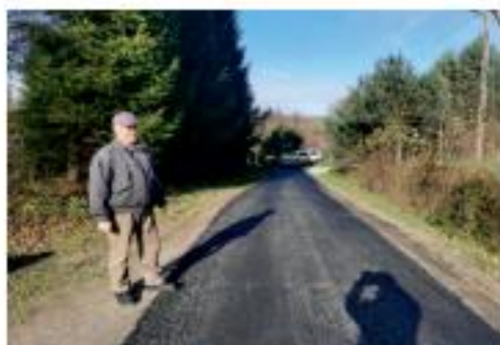
Droga gminna w m. Jawornik Polski Wartość kosztorysowa - 309 303,18 zł Wartość kosztorysu ofertowego - 186 449,06 zł
