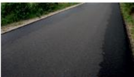
Droga gminna w m. Jawornik-Przedmieście Wartość kosztorysowa - 124 456,74 zł Wartość kosztorysu ofertowego - 45 592,73 zł
