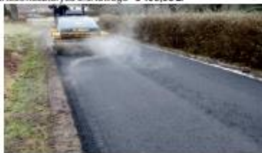
Droga gminna w m. Hucisko Jawornickie
