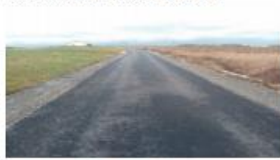
Droga gminna w m. Jawornik Polski Wartość kosztorysowa - 209 782,50 zł Wartość kosztorysu ofertowego - 227 946,92 zł
