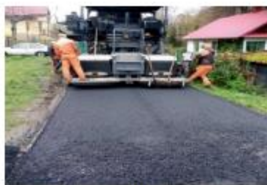
Droga gminna w m. Jawornik-Przedmieście Wartość kosztorysowa - 256 373,56 zł Wartość kosztorysu ofertowego - 83 581,12 zł
