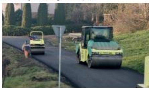
Droga gminna w m. Jawornik Polski Wartość kosztorysowa - 216 258,06 zł Wartość kosztorysu ofertowego - 177 776,82 zł
