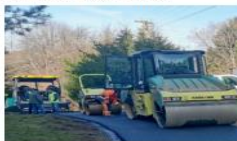
Droga gminna w m. Jawornik Polski Wartość kosztorysowa - 9 178,57 zł Wartość kosztorysu ofertowego - 9 178,57 zł
