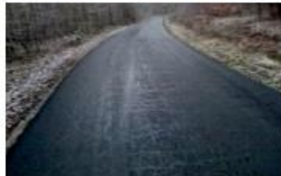
Droga gminna 110603R w m. Manasterz Wartość kosztorysowa - 291 060,00 zł Wartość kosztorysu ofertowego - 225 122,29 zł
