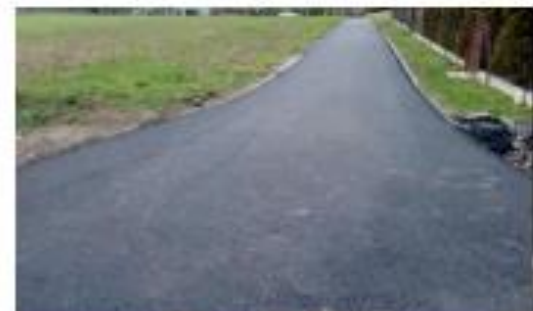
Droga gminna w m. Jawornik-Przedmieście Wartość kosztorysowa - 31 996,69 zł Wartość kosztorysu ofertowego - 25 330,74 zł
